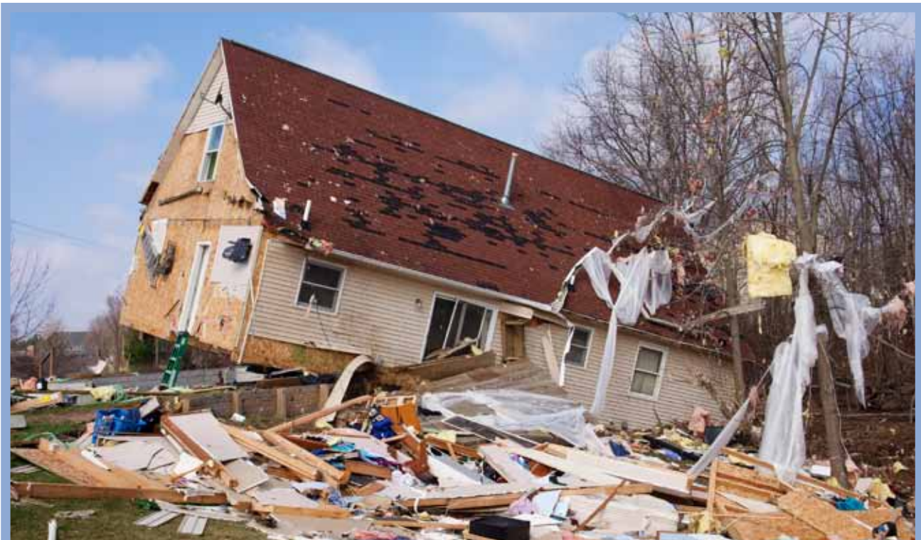
Schäden durch einen Tornado in Lapeer, Michigan, USA.
